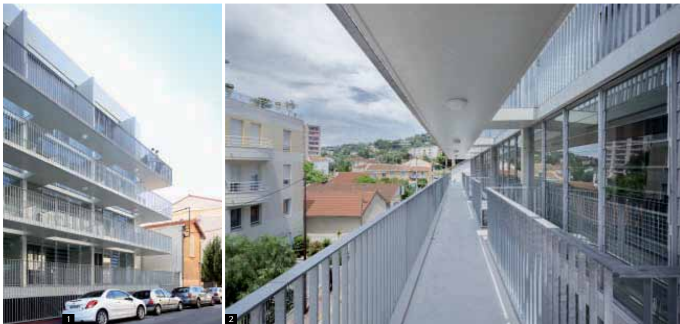
→ 1 • Les coursives fonctionnent comme un empilement de trottoirs. 2 • Sur les coursives, entre rue et logement, le rapport au paysage est constant.
